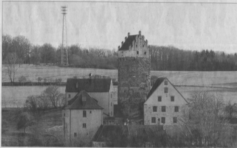
Blick über die Burg Katzenstein hinweg zum inzwischen aufgerichteten O2-Mobilfunkmast. Die Bürgerinitiative Unteres Härtsfeld wendet sich unter anderem gegen diesen Standort für den Mast.
